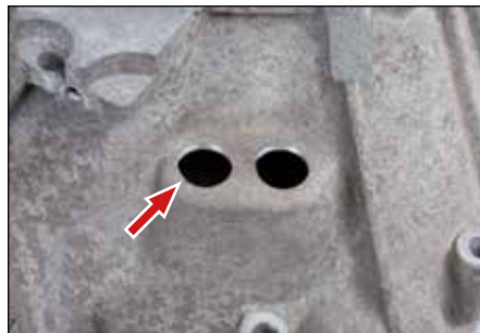
Figur 6: Fjerning av ujevnheter og rengjøring
