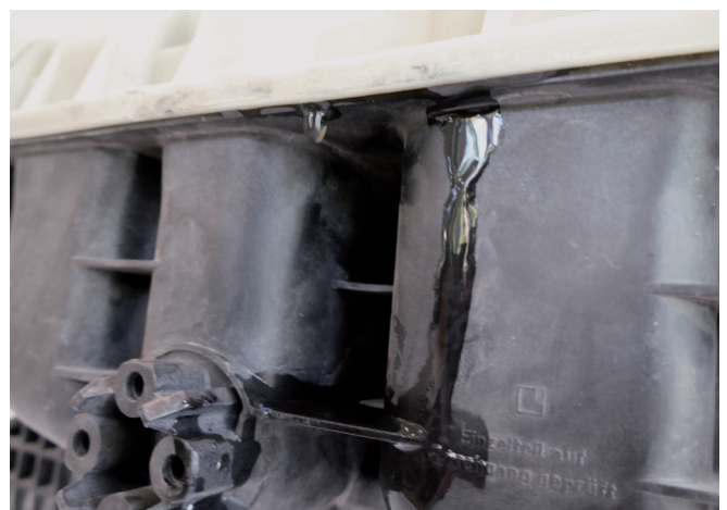
Figure 3 : L'excès de liquide de refroidissement ressort dans la zone du joint de séparation au niveau du vase d'expansion.
