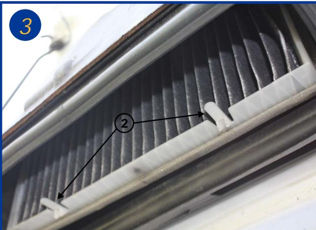
Extraire l'élément filtrant usagé en le soulevant à l'aide des 2 pattes (2). A l'arrière du filtre se trouve un picot de centrage qu'il faudra utiliser pour replacer le nouveau filtre.
